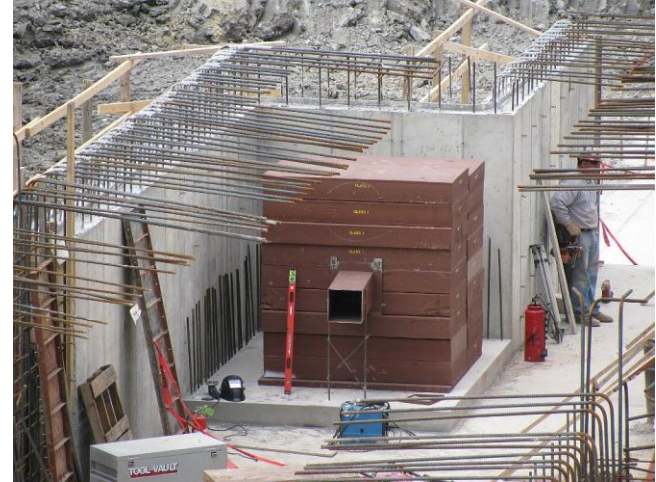
Diagnostic Absorber before concrete pour
