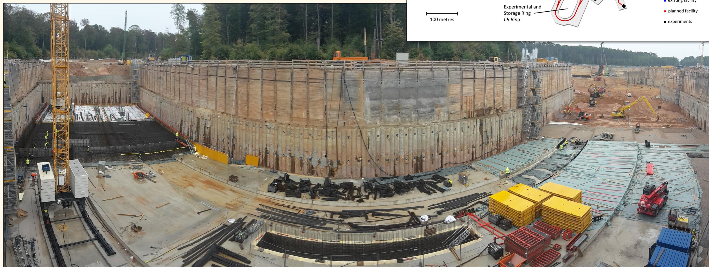
SIS100 tunnel – construction site (Aug. 2018)
