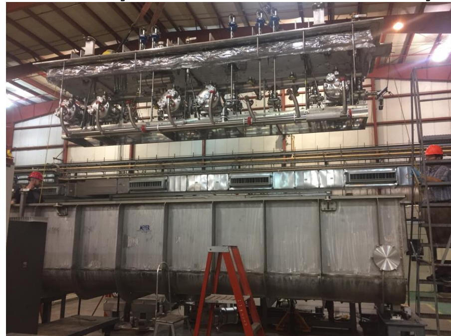
HWR Cryomodule Mock Assembly
