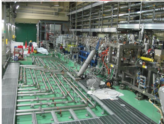
Phase B : Installation du système de refroidissement
